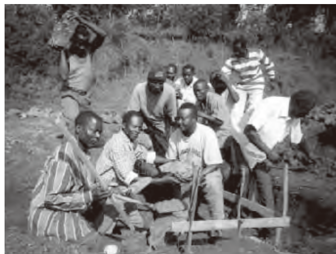
◀ 学校を建設するポポフのメンバー
